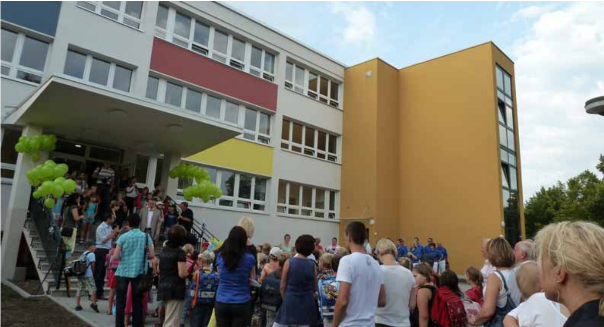
Mit ihren hellen und freundlichen Farben lädt die neu sanierte Grundschule in Zabeltitz zum Lernen ein.
