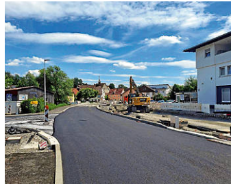
Seit 24. Juni ist die Durchfahrt durch Cappel in Richtung Neuenstein wieder frei. Mitte Juli wird die komplette Ortsdurchfahrt freigegeben. Foto: Stadt Öhringen
