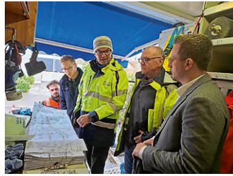
Rainer Neuberg vom Stadtbauamt erklärt die Sanierungsarbeiten vor Ort Fotos: Stadt Öhringen
