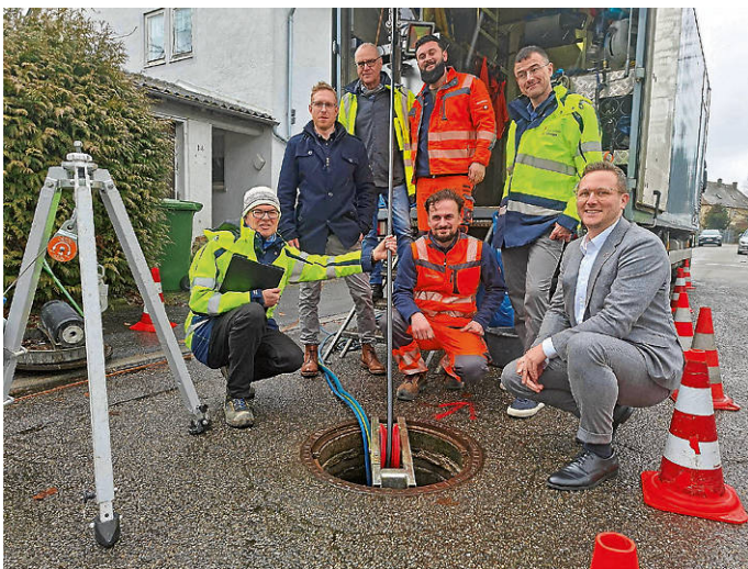
Das Team der Fa. Geiger und die Verantwortlichen der Stadt Öhringen freuen sich, dass die Arbeiten im Zeitrahmen sind und ohne die Straßen aufzureißen durchgeführt werden können.
