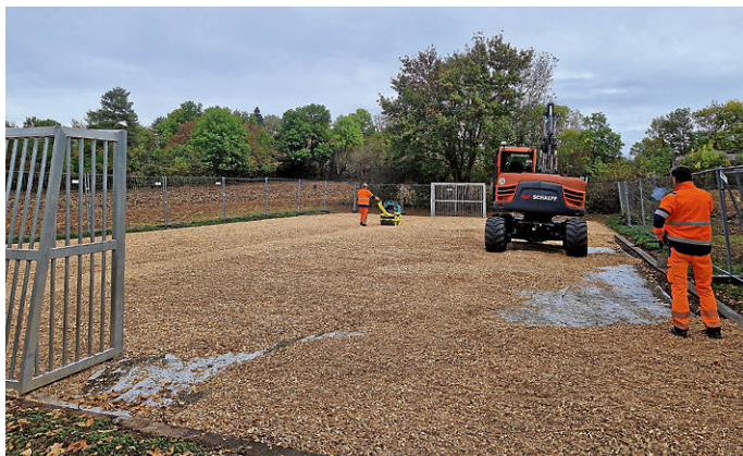
Frische Hackschnitzel für den Bolzplatz an der Alten Pfedelbacher Straße Foto: Stadt Öhringen
