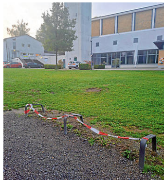
Leider werden wiederholt Sitzbänke durch Vandalismus schwer beschädigt und müssen deswegen instand gesetzt werden. Foto: Stadt Öhringen
