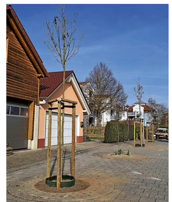
Der städtische Bauhof legt neuerdings Gießringe um den Stamm, um das Wasser direkt an den Wurzelballen zu leiten
