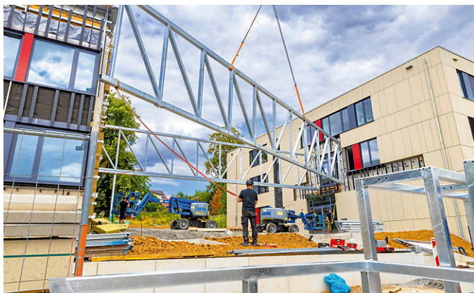
Einhängen der Gebäudebrücke am HGÖ Foto: Marcel Milbich
