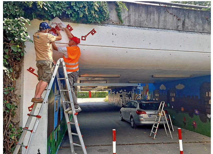
Gerd Metzler und Manfred Goldbaum setzen den Feinschliff an der Neugestaltung der Römerbadunterführung Foto: Stadt Öhringen
