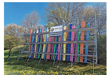
Auffrischung der Landesgartenschau-Stelen durch den städtischen Bauhof
