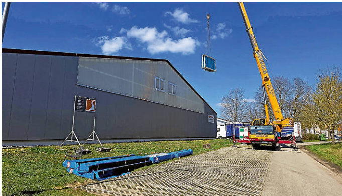
Anlieferung der neuen Padelplätze auf der Tennisanlage im Steinfeld Fotos: TSG Hohenlohe
