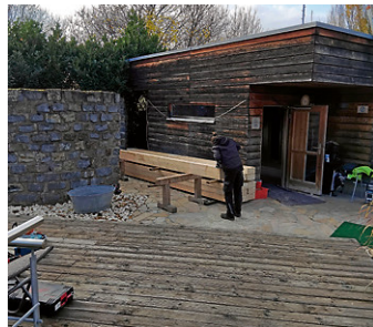
Das Dach der Außensauna wurde instandgesetzt
