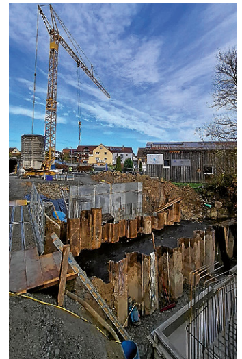
Fundamente der neuen Straßenbrücke Foto: pr
