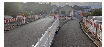
Zwei Ersatzbrücken an der Ortsdurchfahrt Cappel, links die Spur für Autos, rechts für Rad- und Fußgänger Foto: Stadt Öhringen
