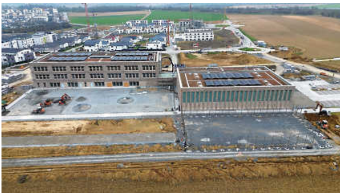
Aus der Luft ist der Bereich des Schulhofs der neuen Grundschule im Limespark gut zu erkennen Foto: Stadt Öhringen
