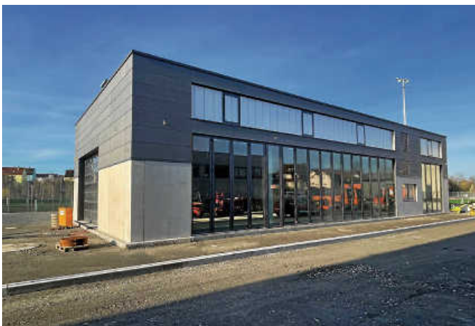
Die neue Fahrzeughalle ist an der Fassade bereits verkleidet
