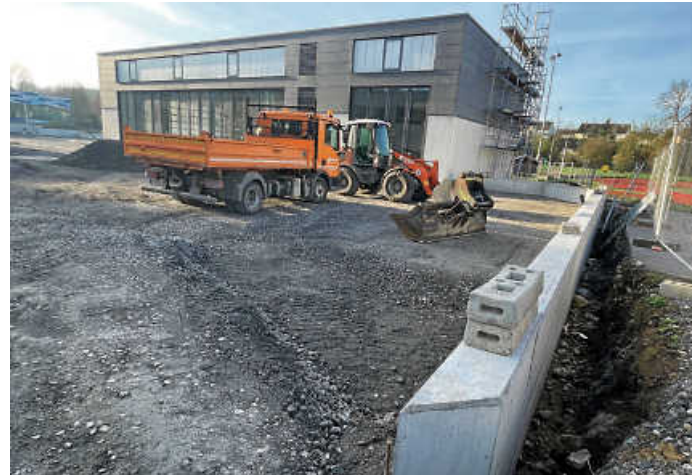
Die Außenanlagen am Feuerwehr-Gelände bekommen Form
