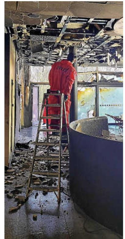
Untersuchung der Brandschäden durch eine Spezialfirma an der Hallenbaddecke
