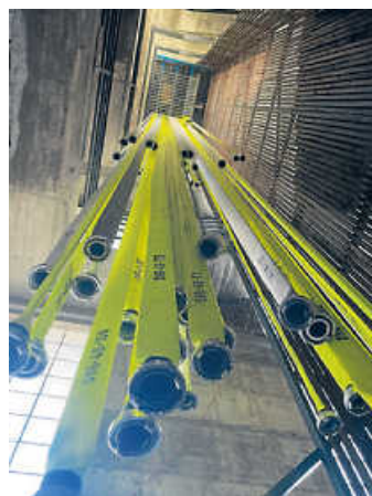
Blick von unten in den 28 Meter hohen Schlauchturm, wo die Schläuche zum Trocknen aufgehängt werden
