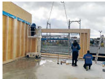
Stellen der Holzbauwände
