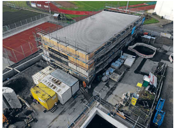
Die neue Fahrzeughalle, im Hintergrund der neu sanierte Bolzplatz
