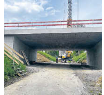
Die neue Brücke über den Betonweg wurde poliert. Ab dem 4. Juli ist der Durchgang unter der neuen Brücke wieder möglich
