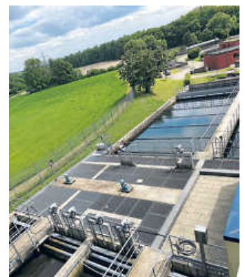
Die 4. Reinigungsstufe der Öhringer Kläranlage
