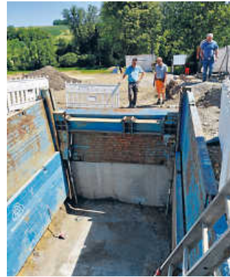
Grube für die neuen Rohre zur Entwässerung der Römerallee
