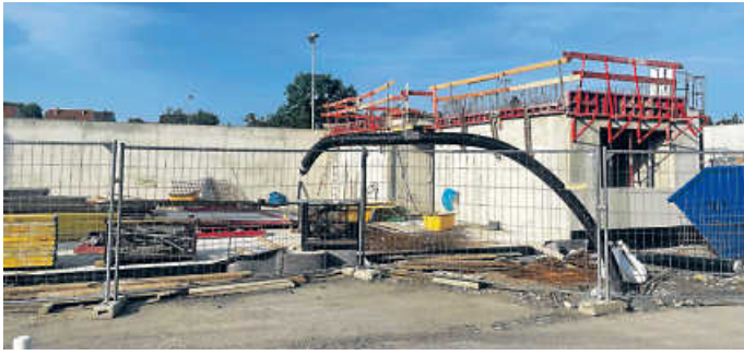
Südlich auf dem Grundstück entsteht die neue Fahrzeughalle
