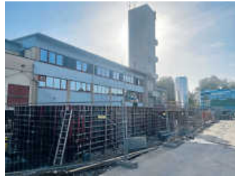
Direkt am FFW-Gebäude entsteht ein Anbau
