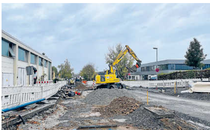
Straßenarbeiten in der Kastellstraße
