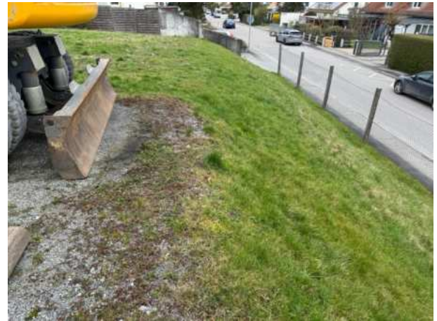
Abb. 7: Rand des geplanten Baufelds auf Flst.-Nr. 1956 mit zur Straße abfallenden Böschung.
