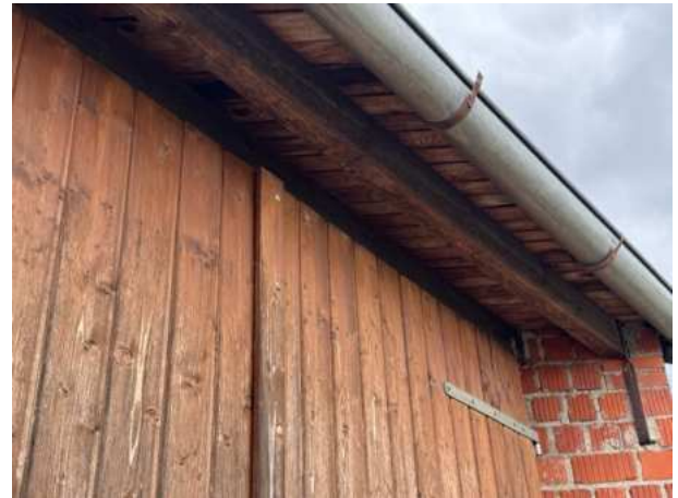
Abb. 13: Betriebsgebäude ohne Zugangsmöglichkeit und ohne Nutzungsspuren von Tieren.
