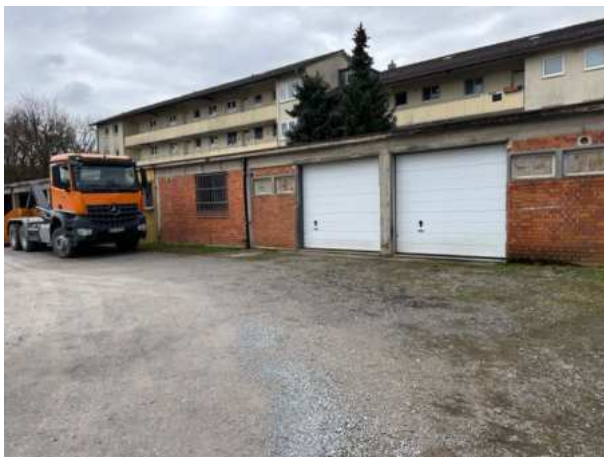
Abb. 14: Betriebsgebäude ohne Zugangsmöglichkeit und ohne Nutzungsspuren von Tieren.
