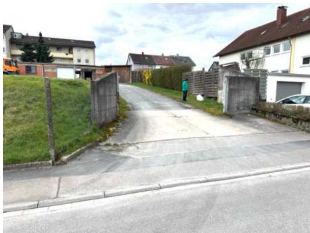
Abb. 4: Eingeschotterte Zufahrt auf das Anwesen im Westen des Plangebiets.
