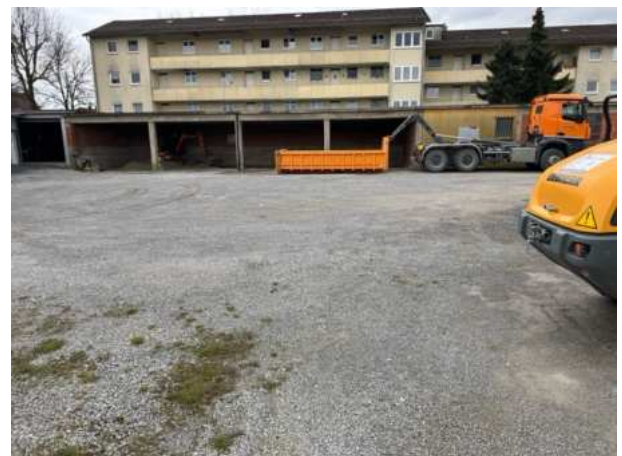
Abb. 11: Tierökologisch unbedeutende Betriebsgebäude im Süden von Flst.-Nr. 1956/1 mit verdichteter Schotterfläche.
