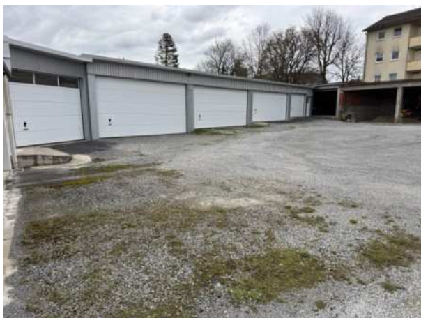
Abb. 10: Tierökologisch unbedeutende Betriebsgebäude im Osten von Flst.-Nr. 1956/1 mit verdichteter Schotterfläche.
