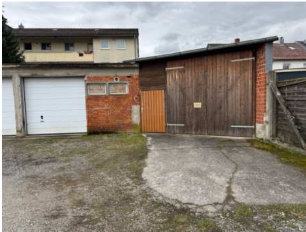
Abb. 12: Betriebsgebäude ohne Zugangsmöglichkeit und ohne Nutzungsspuren von Tieren.
