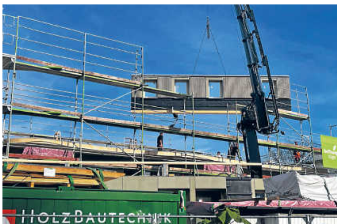
Besonders beeindruckend war das Einschweben der Fertigbauteile aus Holz auf der Baustelle der Hoffnungshäuser
